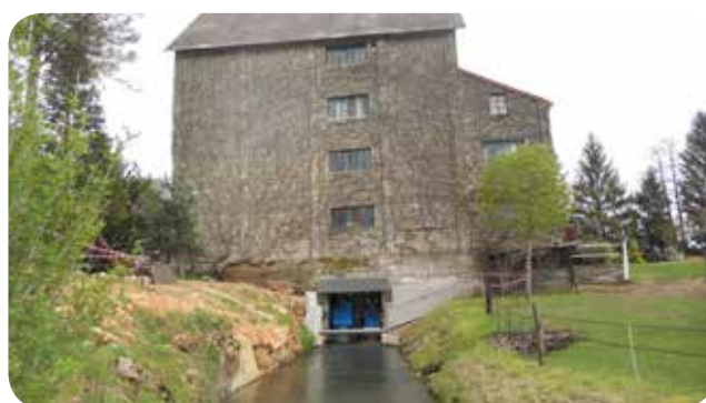
▷ Vue d'ensemble du bâtiment avec la nouvelle chambre d'eau et l'implantation des turbines en sortie du moulin
