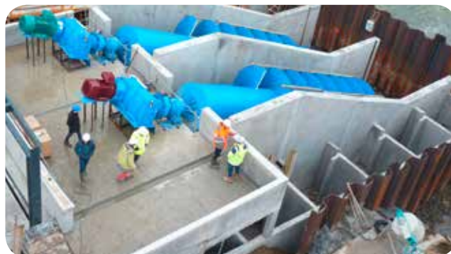
➤ Installation des vis hydrodynamiques et construction de la passe à poissons à bassins successifs (en bas à droite)
