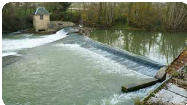
➤ Vue avant travaux : le barrage et, au fond, l'ancienne centrale qui sera remplacée par deux vis hydrodynamiques et une passe à poissons
