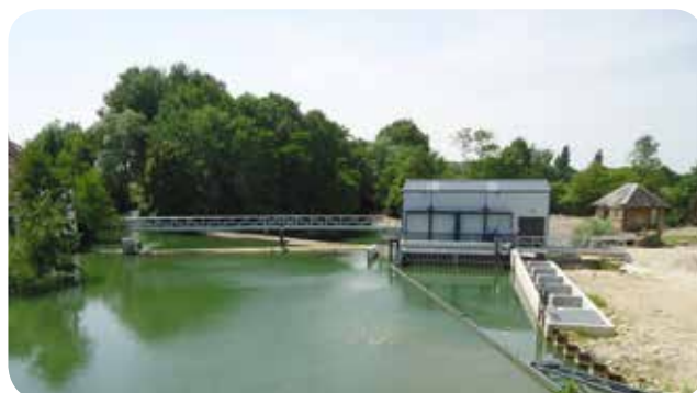
➤ Vue d'ensemble après travaux : prise d'eau avec drome et dégrilleur, passe à poissons à bassins successifs, local technique avec passerelle d'accès
