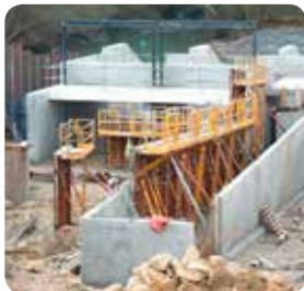
▶ Travaux de génie civil pour l'installation des vis hydrodynamiques et de la passe à poissons
