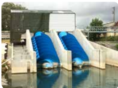
▷ Vue d'ensemble après travaux.
