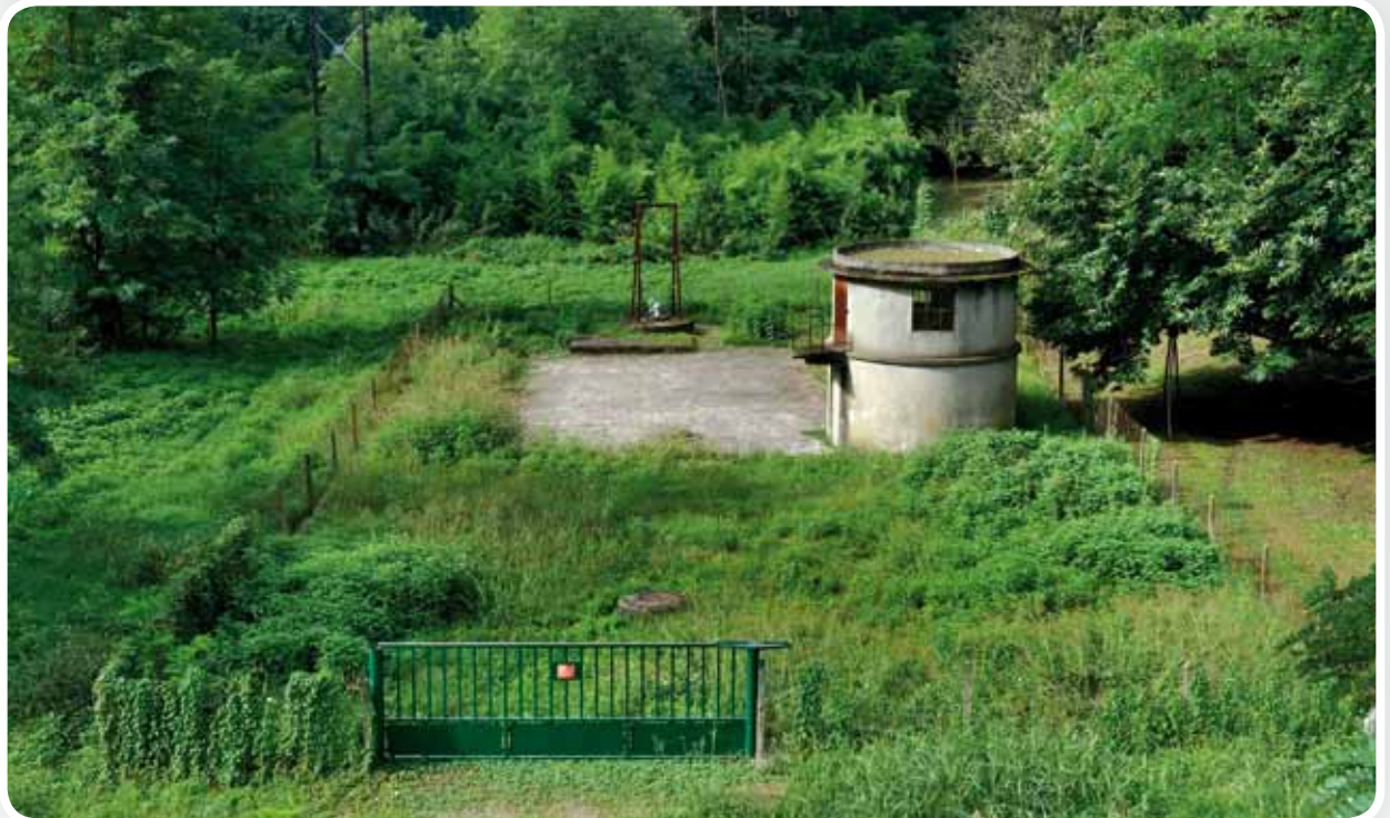
Station de captage d'eau potable
